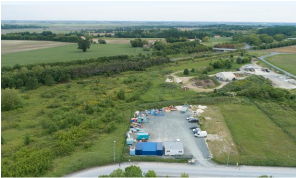
A - Parcelles occupées en partie : entreprise etd épots CTM au nord estd e la zone UX
