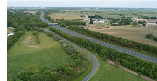
B - Espaces enherbés et secteur de bassin pluvial entre I4a837 et les parcelles aménagées-bâties (ZA nord)
